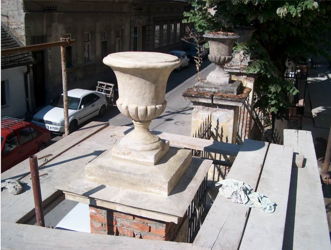
Zemun, Hram Svetog Oca Nikolaja: Vaza i kapitel od kamena posle čišćenja, restauracije i konzervacije i vaza i kapiteli koji nisu rađeni (u pozadini)
