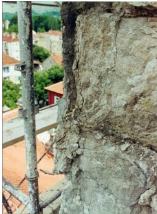
Trebinje, Saborni hram (balkon, južna i severna fasada): Oštećenja na kamenu
